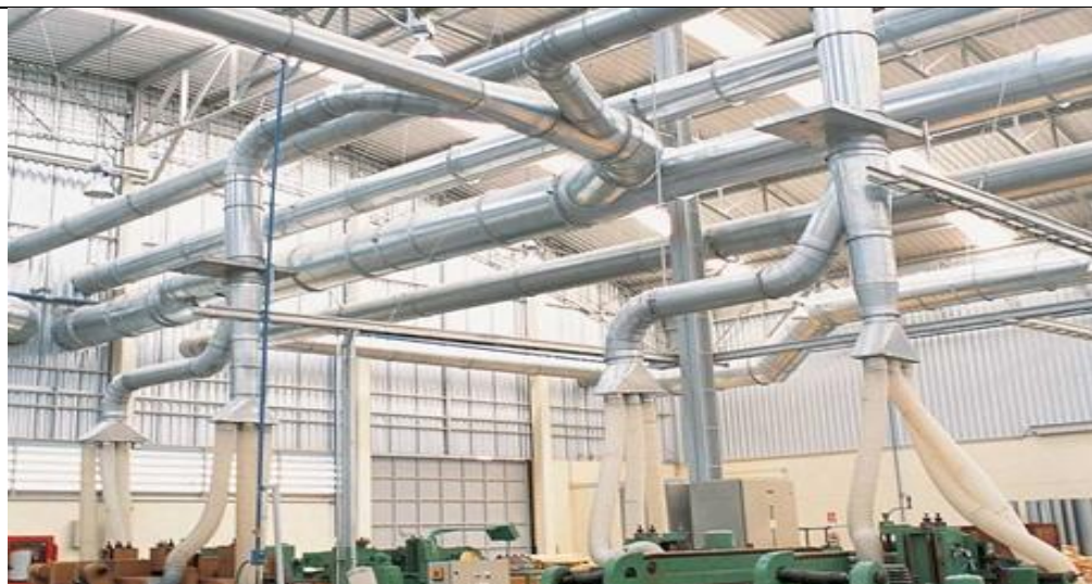
Hình 18. Mô hình tham khảo hệ thống thu gom bụi nhà xưởng
