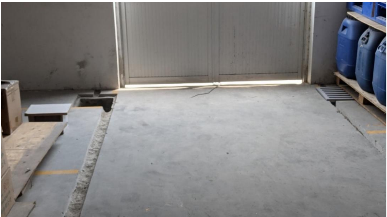
Hình 4. 18. Kho chứa hóa chất của dự án
